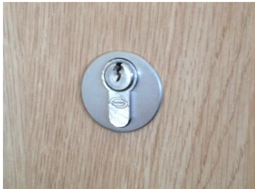
oplegslot voor profielcilinder (exclusief profielcilinder)
